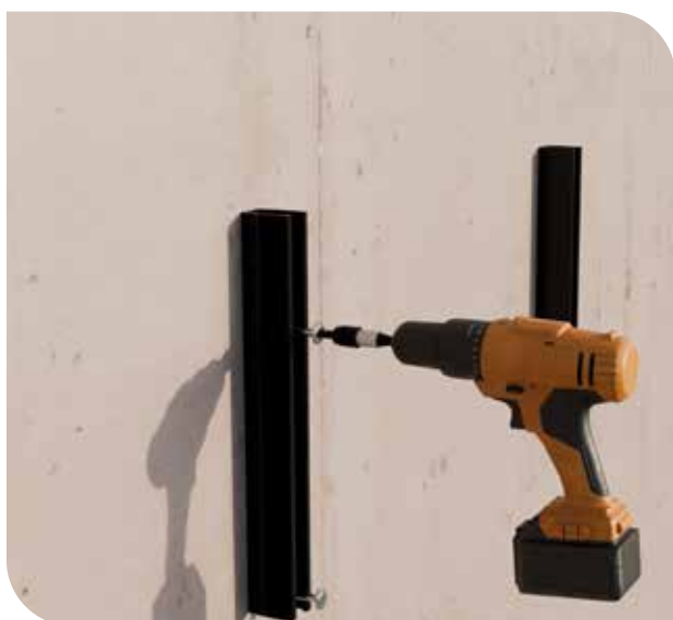
SCHRITT 3: Basisprofil ausrichten und mithilfe von der HSeasy PRO Tellerkopfschraube A2 befestigen. Bei Fassaden mit Dämmung alternativ Gewindestange M8, Edelstahl A2 verwenden (siehe optionale Schritte am Ende der Anleitung).
