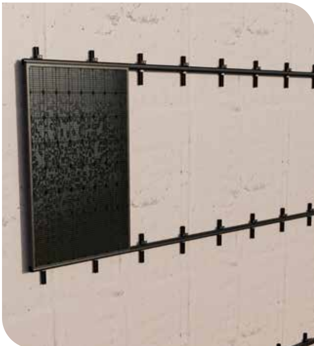
SCHRITT 10: Eingelegtes Solarmodul
