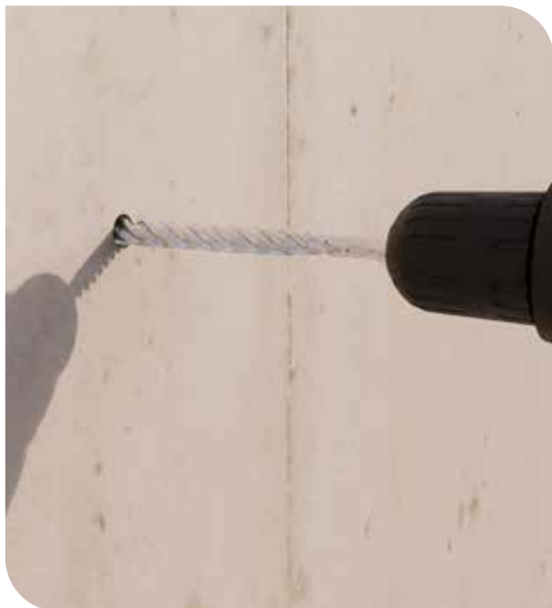
SCHRITT 1: Bohrlöcher für Dübel vorbohren. Pro Basisprofil sind zwei Bohrlöcher erforderlich.
