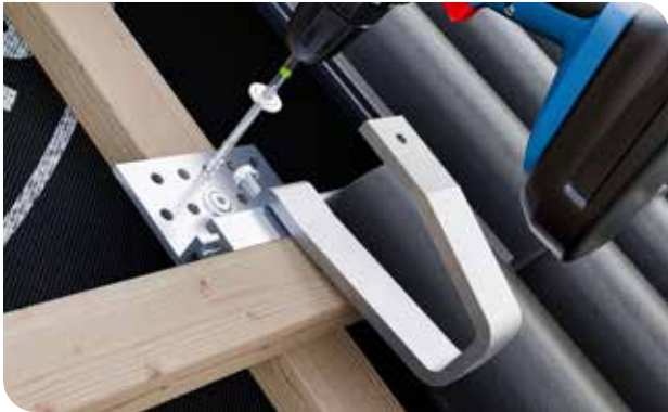
SCHRITT 1: Dachhaken LayTec an die Konterlatte schrauben.
