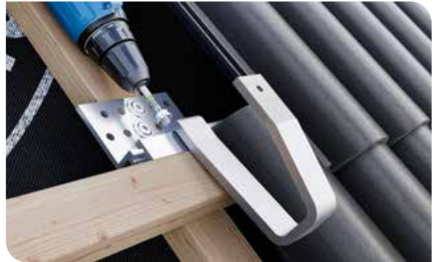
SCHRITT 2: Dachhaken LayTec in die richtige Position bringen und arretieren.
