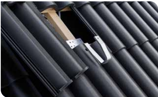
SCHRITT 3: Entnommene Dachpfanne wieder einsetzen.
