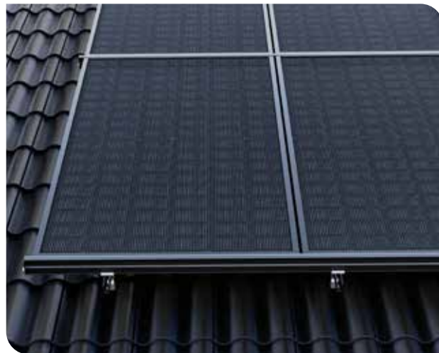
SCHRITT 19: Nachdem alle Solarmodule eingesetzt und die Endkappen montiert sind, ist das Einlegesystem vollständig aufgebaut.
