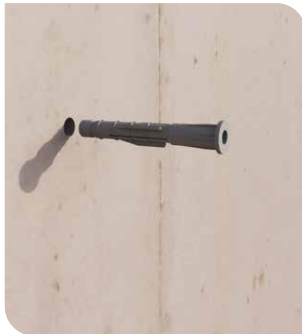
SCHRITT 2: Dübel einsetzen.
