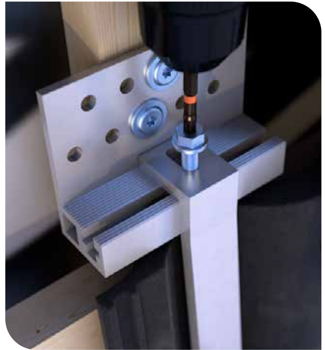
SCHRITT 2: Positionieren Sie den Haken und befestigen Sie ihn.
